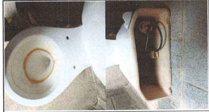
Foto 5: Se observa el sanitario del modulo 2
