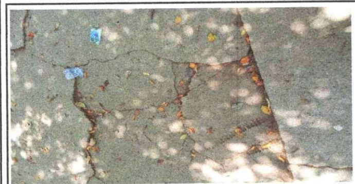
Foto 3: Se observa el deterioro de la torta de cemento en el patio de la escuela.
